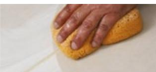
Limpie la superficie del revestimiento luego del emboquillado, tenga en cuenta las recomendaciones sugeridas en la ficha técnica según el tipo de boquilla que utilice, cementicia o epóxica.
