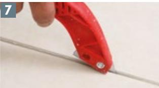
Con un martillo de goma retire las campanas del sistema TILE LEVEL QUICK utilizado en la nivelación, remueva el PEGACOR® sobrante de las ranuras y limpie los residuos de la superficie con una esponja húmeda.
