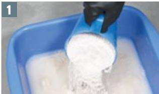
En un recipiente limpio mezcle el PEGACOR® con agua limpia según la dosificación indicada en el empaque, hasta obtener una mezcla de consistencia cremosa y libre de grumos. Se sugiere agregar el PEGACOR® al agua, para facilitar la mezcla.
