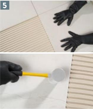
Durante la instalación, levante aleatoriamente algunas tabletas para verificar que tengan 100% cobertura de pegante, sobre todo en los bordes y esquinas. En formatos grandes es crítico no contar con una total cobertura de pegante, las zonas que no tengan buena cobertura acumularán agua generando manchas de humedad y/o se quiebran con el tráfico.
