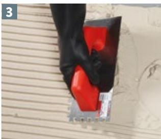
Aplique PEGACOR® sobre la superficie con el lado liso de la llana haciendo presión y extiéndalo con el lado dentado inclinándola 60°. Aplique sólo la cantidad que pueda cubrir de 10 a 15 minutos. Cuando las piezas son rectangulares la aplicación del adhesivo debe ser en la dirección paralela del lado de menor tamaño del revestimiento, lo anterior facilita la salida del aire atrapado y mejora el cubrimiento o el contacto del adhesivo con el revestimiento.
