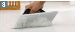
Emboquille de 24 a 36 horas después de la instalación. Seleccione el CONCOLOR® de acuerdo al ancho de la junta, elija el color y aplique según las recomendaciones de la ficha técnica del producto.
