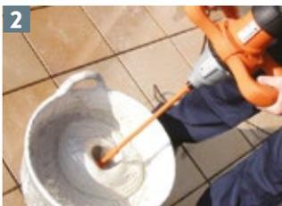
Deje reposar la mezcla de 5 a 10 minutos y revuelva nuevamente antes de usar. No aplique PEGACOR® que ha comenzado a fraguarse, ni trate de "arreglarlo" adicionándole más agua. Se sugiere el uso de las herramientas especificadas para la mezcla del pegante que garantiza la homogenización para su óptimo desempeño.
