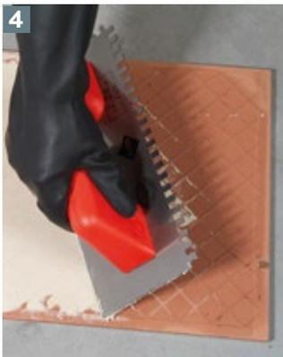
Para la instalación de piezas grandes, en TODOS los casos se debe realizar doble encolado, que consiste en aplicar el adhesivo con la parte plana de la llana en la cara posterior de la tableta (adicional al aplicado sobre el sustrato), haciendo presión para que el adhesivo penetre los poros de la pieza mejorando así la adherencia al sustrato.
